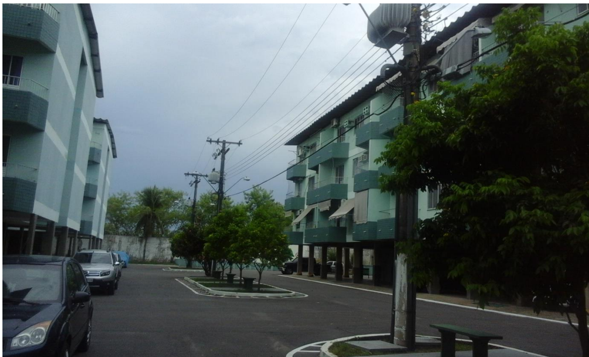
Figura 34 - Edifício Sol Morar – Manaus
