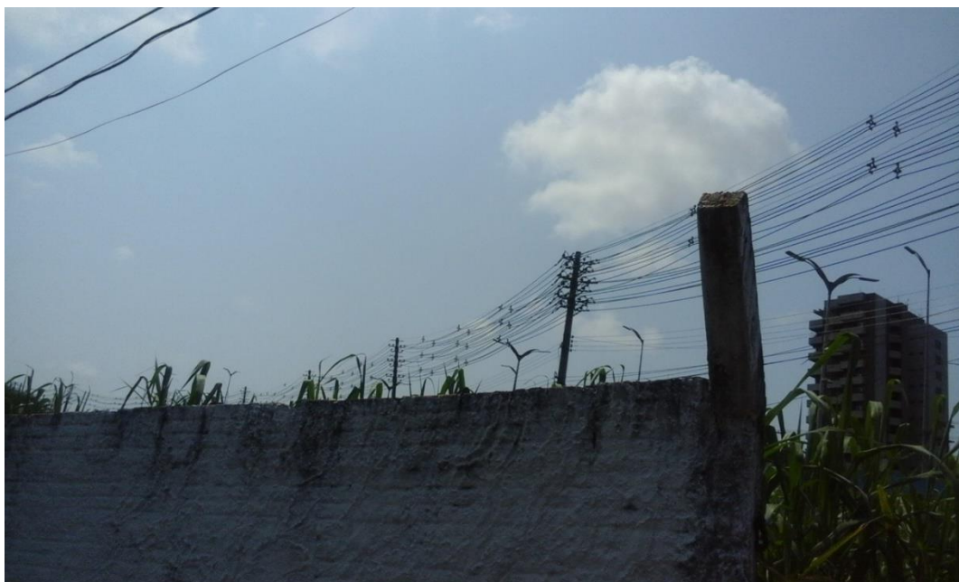
Figura 48 - Vista entorno imediato da edificação
