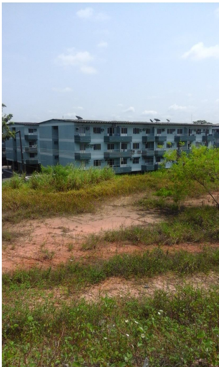
Figura 50 - Vista da edificação
